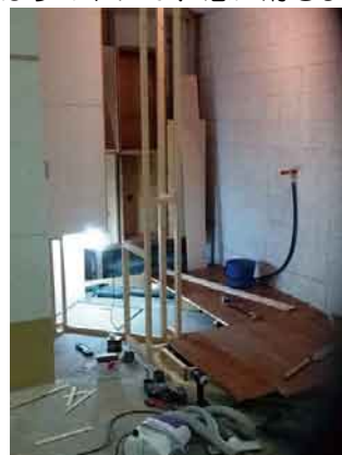
今は大工さんとして地下のトイレスペースを作っています。
